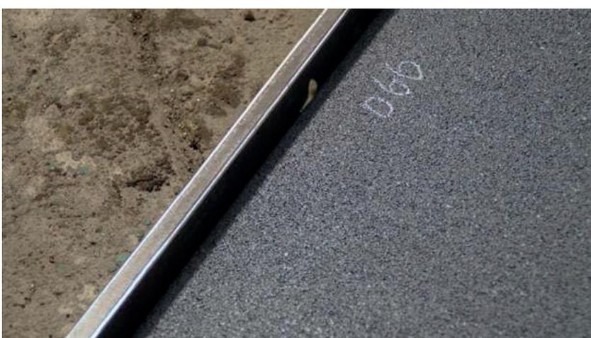
**5** Через 24 часа (при температуре выше 10°C) можно снимать оправку и продолжать монтаж покрытия. Дальнейшая укладка может производиться как с использованием оправки (при необходимости), так и без неё (при минимальном зазоре).
